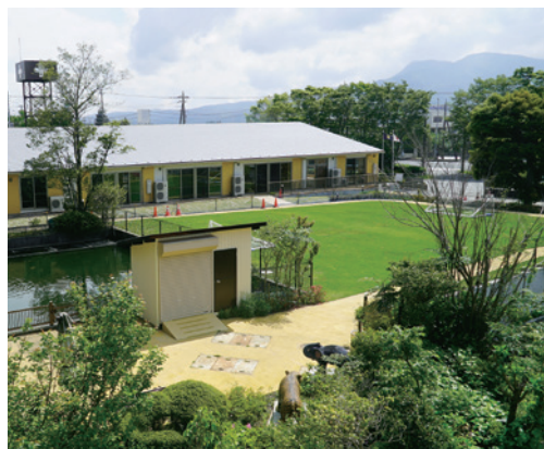
フジ虎ノ門子どもセンター外観
